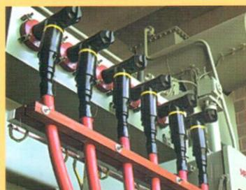
سرکابل های چپقی این شرکت ساخت شرکت UE/GCA است. جنس این اتصالات از سیلیکون رابر و برای اتصال کابل های برق فشار متوسط به تابلوهای کمپکت تا سطح ولتاژ ۳۶ کیلوولت طراحی و ساخته می شوند.
